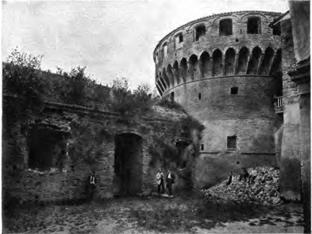
ROCCA DI BAGNARA — VEDUTA DEL TORRIONE SFORZESCO E DELL'INTERNO DELLA CORTINA A SUD
